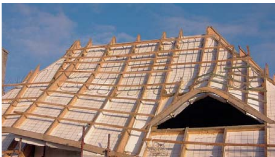
Układanie bariery termicznej dachu pomiędzy warstwami ocieplenia, firma ISOMAX / Installing the thermal barrier layer between the insulation layers, ISOMAX company
