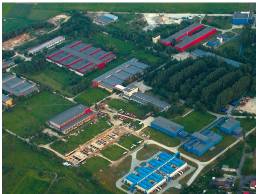
Zakład Uzdatniania Wody w Goczałkowicach/ Water Treatment Facility in Goczałkowice
